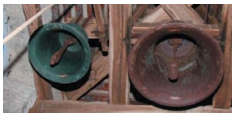
Zvony před rekonstrukcí zvonice
