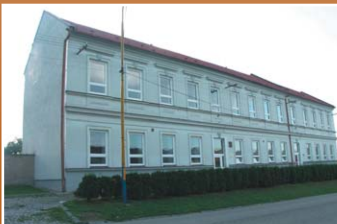
Nová okna a dveře na budově staré školy
