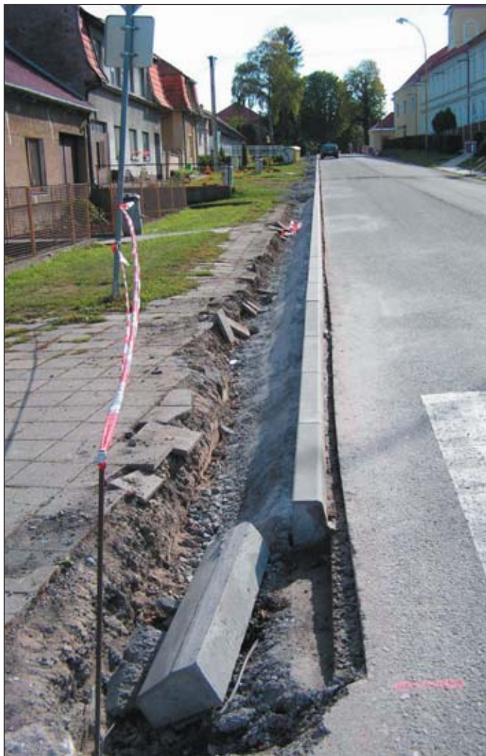
Budování chodníku na Plánávách
