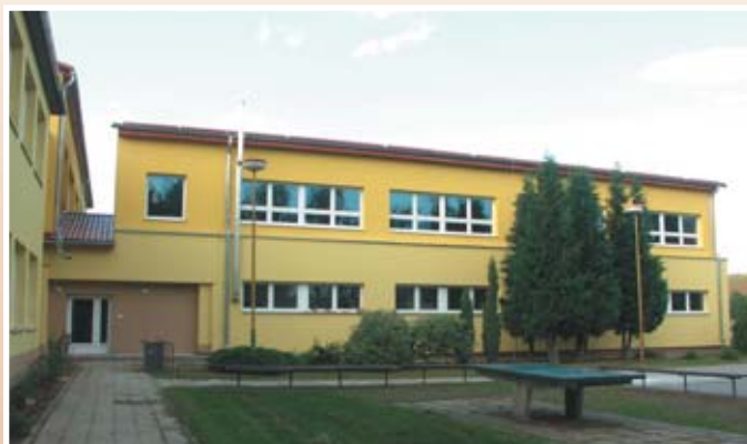
Přístavba galerie nad tělocvičnou a nový vstup do budovy
