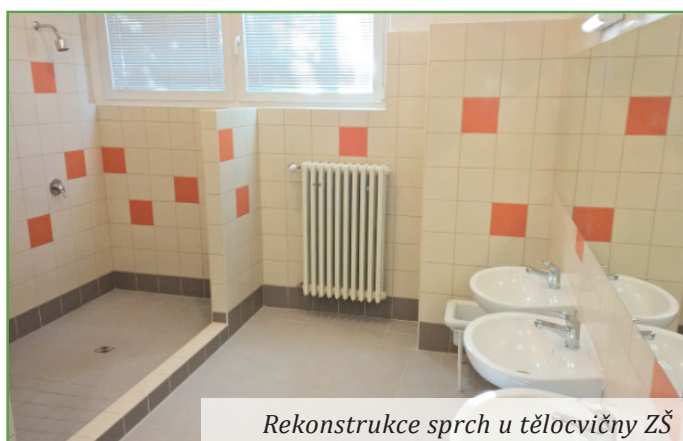
Rekonstrukce sprch u tělocvičny ZŠ
